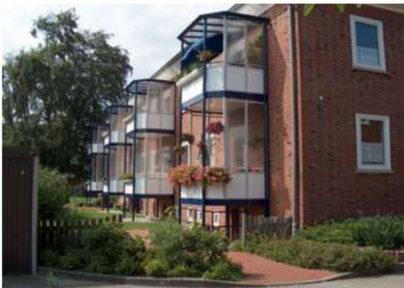
Foto: Erneuerungsmaßnahmen Bauverein – Balkone, Außenanlagen
