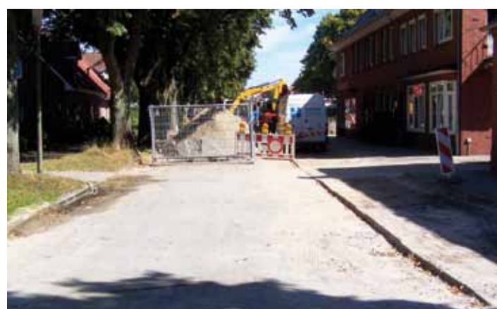
Baumaßnahmen in der Johannstraße
