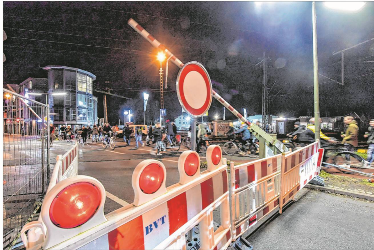
Bis Mitte Februar bleibt der Bahnübergang geschlossen.
