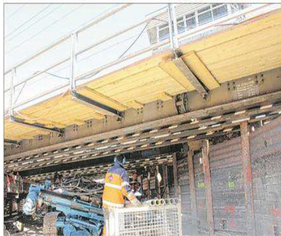
Mit schwerem Gerät arbeiten die Bauarbeiter am Tunnel.
