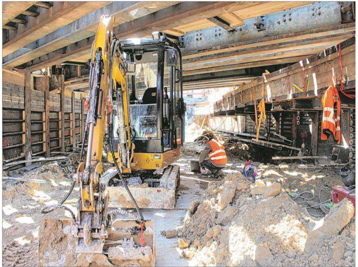
Ein Bagger steht unter den Gleisen am Bahnübergang Bremer Straße. Die Bauarbeiten kommen gut voran.
