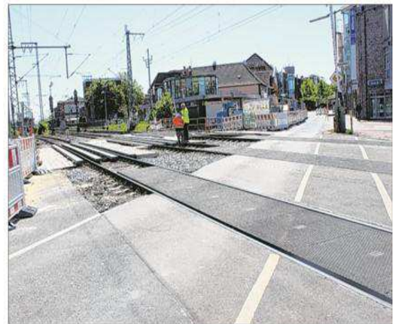
Oberirdisch ist an der Bremer Straße nicht viel zu sehen.
