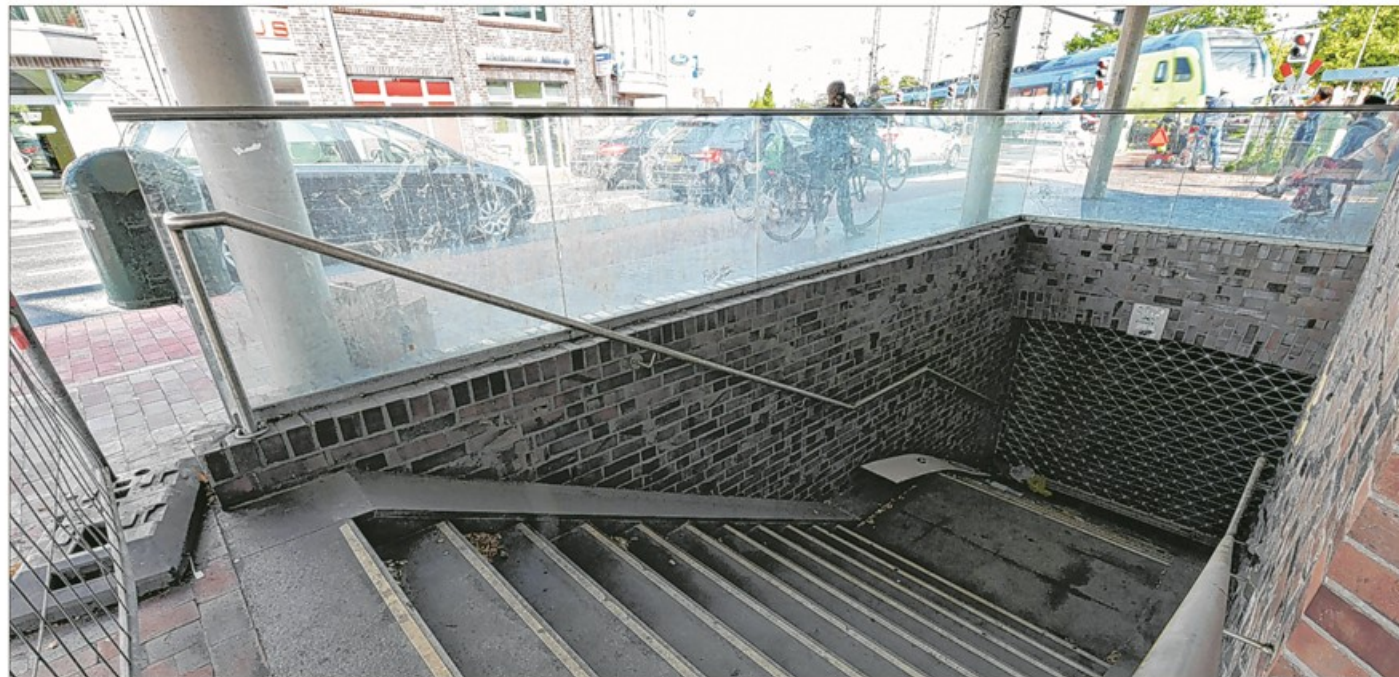
Kein Durchkommen gibt es seit Mitte 2013 am Fußgängertunnel an der Bremer Straße.
