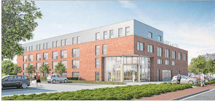
92 Pflegeplätze entstehen in dem neuen Seniorenzentrum.
