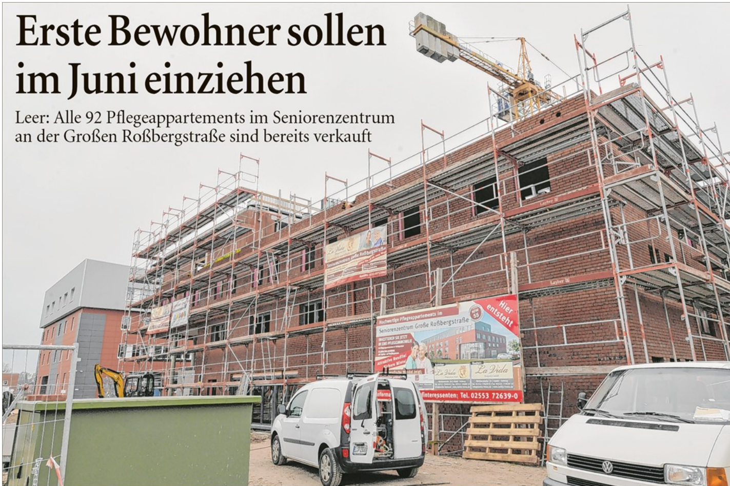
Direkt neben der Ludwig-Fresenius-Schule (links) wird das Seniorenzentrum gebaut.
