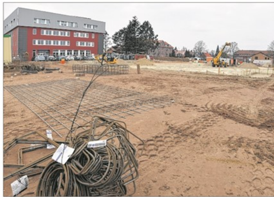
Direkt neben der Ludwig-Fresenius-Schule entsteht das neue Seniorenwohnheim.
