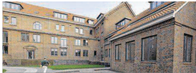
Ab Dezember können die Wohnungen im Rampengebäude bezogen werden. BILD: ORTGIES
