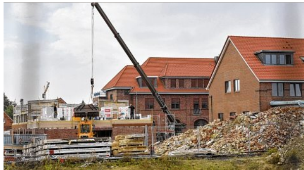
Hier kann man ab Dezember einziehen: Die Wohnungen im Rampengebäude sind fast fertig.
