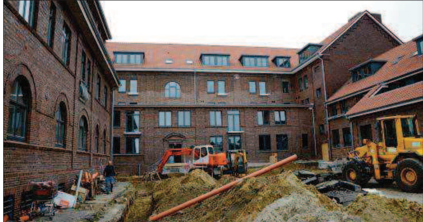
Das 1928 erbaute Gebäude erstrahlt in neuem Glanz. Vor die Terrassentüren (hinten) werden noch französische Balkone gebaut. Fotos: Antje Jansen
