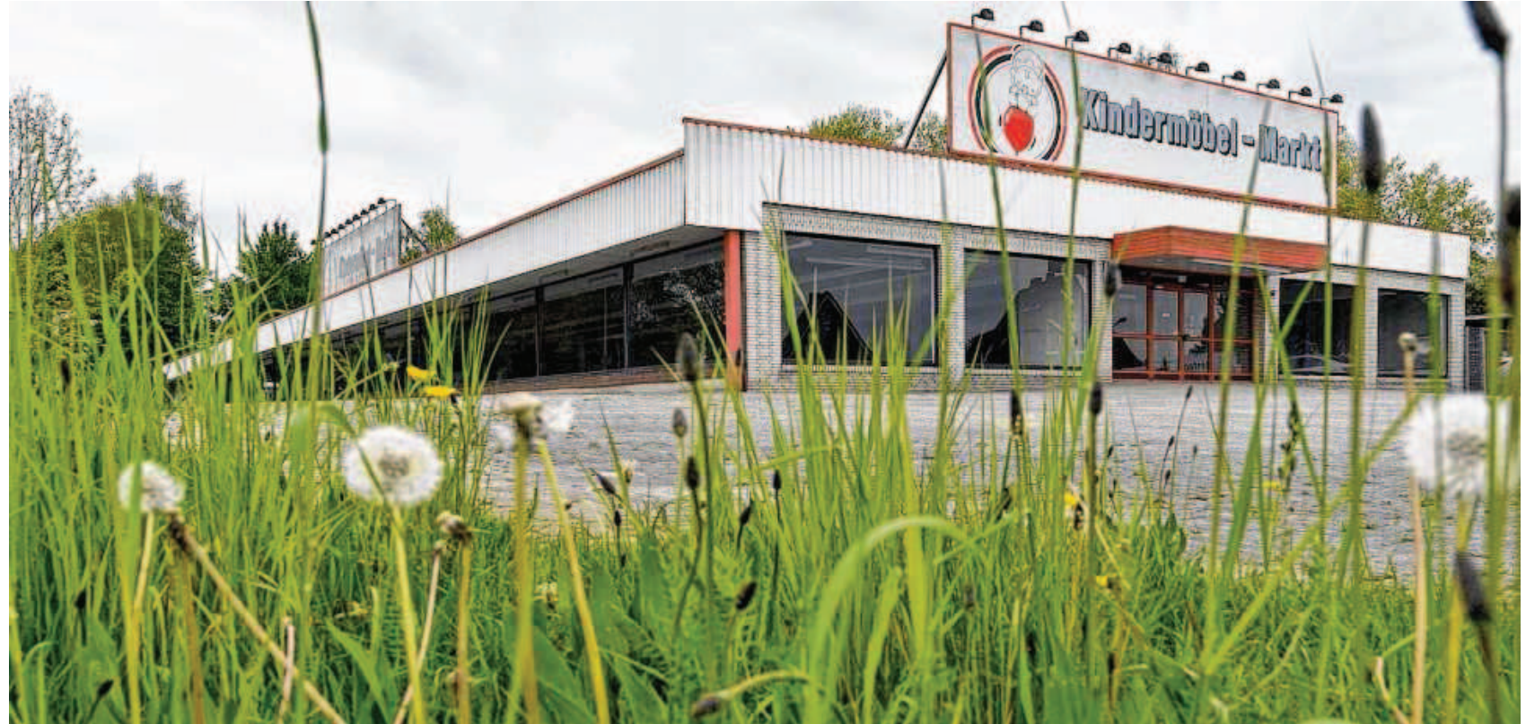
Steht weiter leer: der ehemalige Kindermöbel-Markt am Osseweg.
