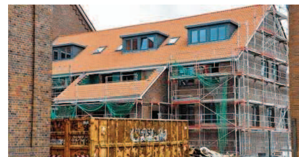
In den Verwaltungsgebäuden auf dem MZO-Gelände werden neue Wohnungen gebaut.
