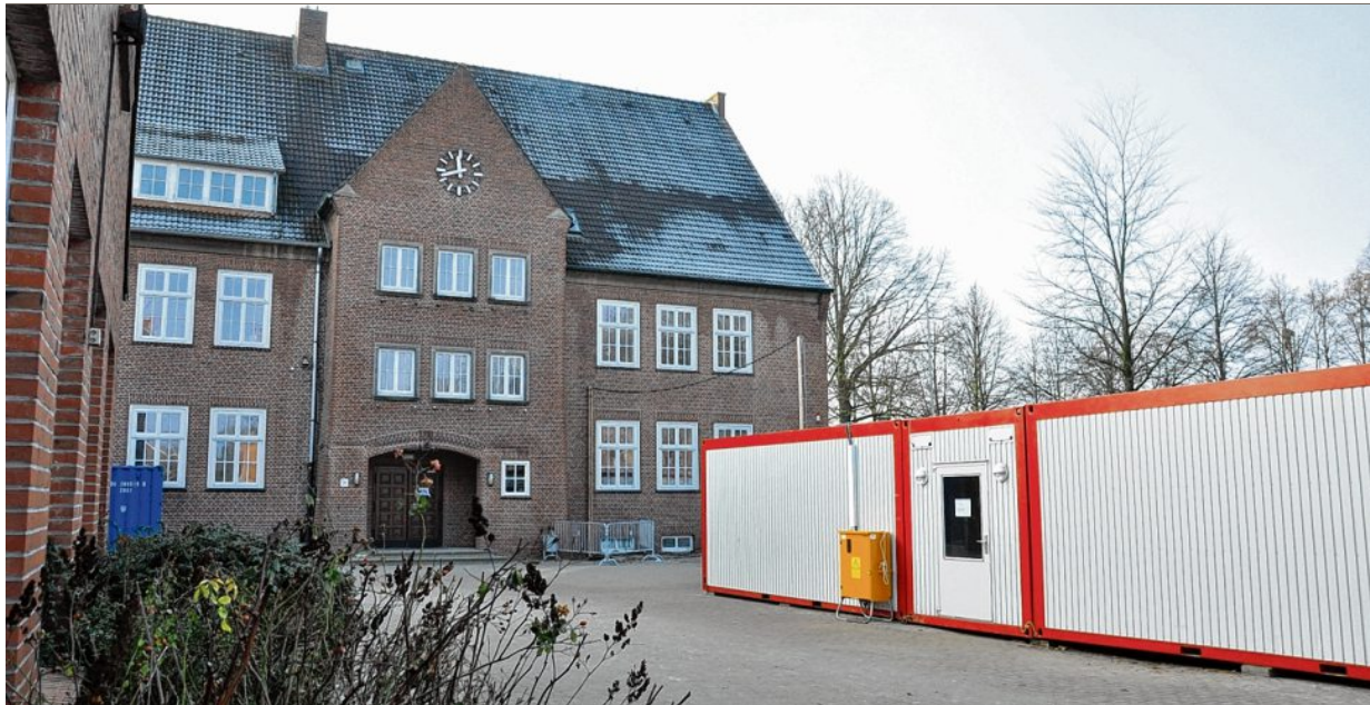
Auf dem Gelände der Hoheellernschule stehen auch immer noch Container, in denen die Kinder während der Sanierungsarbeiten unterrichtet werden.
