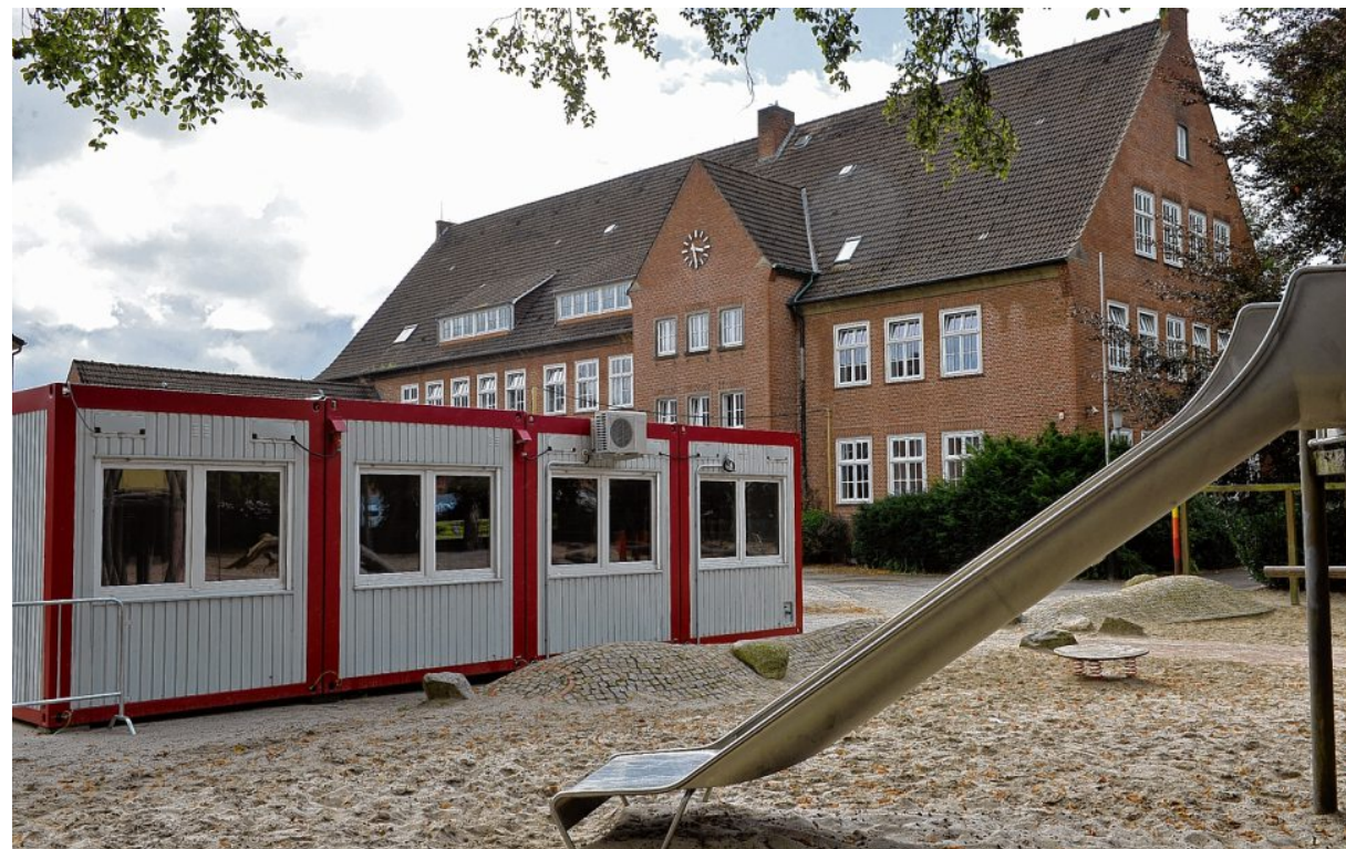
Im Hof der Hoheellernschule stehen bereits 14 Container.
