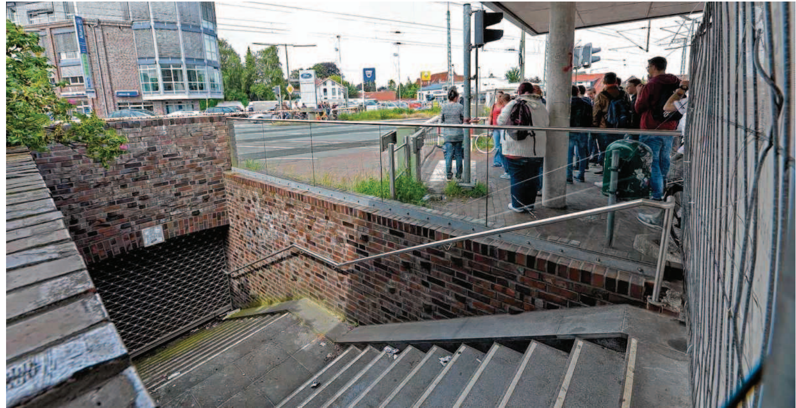
Das Gitter bleibt unten: Seit rund zweieinhalb Jahren ist der Tunnel an der Bremer Straße schon gesperrt.
