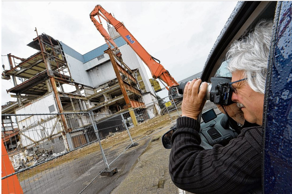
Bruno Haacke fuhr gestern am MZO-Gelände vorbei und machte schnell ein Foto von den Abrissarbeiten. BILDER: ORTGIES
