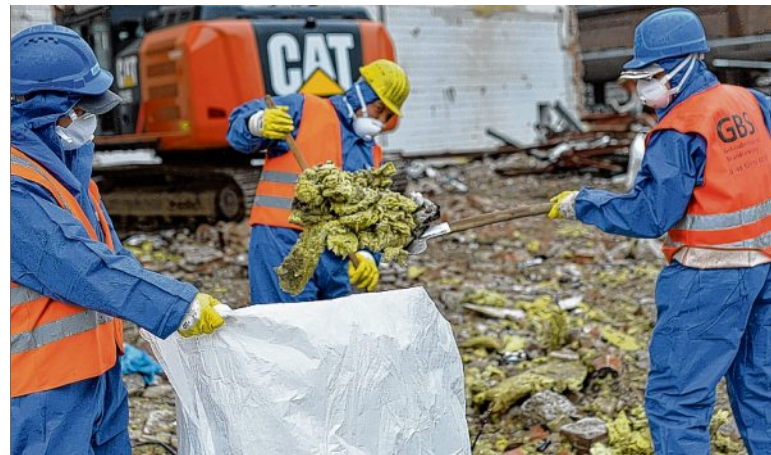
In Schutzanzügen und mit Mundschutz entsorgen die Mitarbeiter die alte Asbestfüllung aus dem MZO-Turm.
