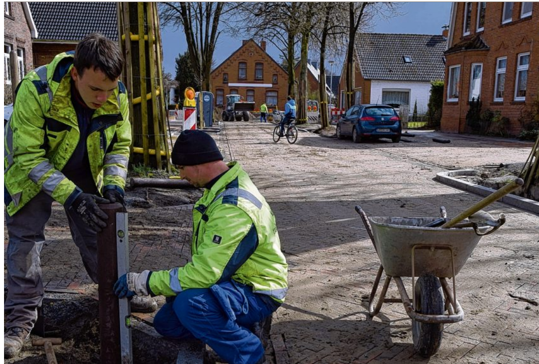
Mitarbeiter der Emdar Firma Huchtman setzen gestern in der Ulrichstraße mehrere Dutzend Poller ein. Der Straßenausbau soll Mitte April abgeschlossen sein. BILD: BEHRENDT
