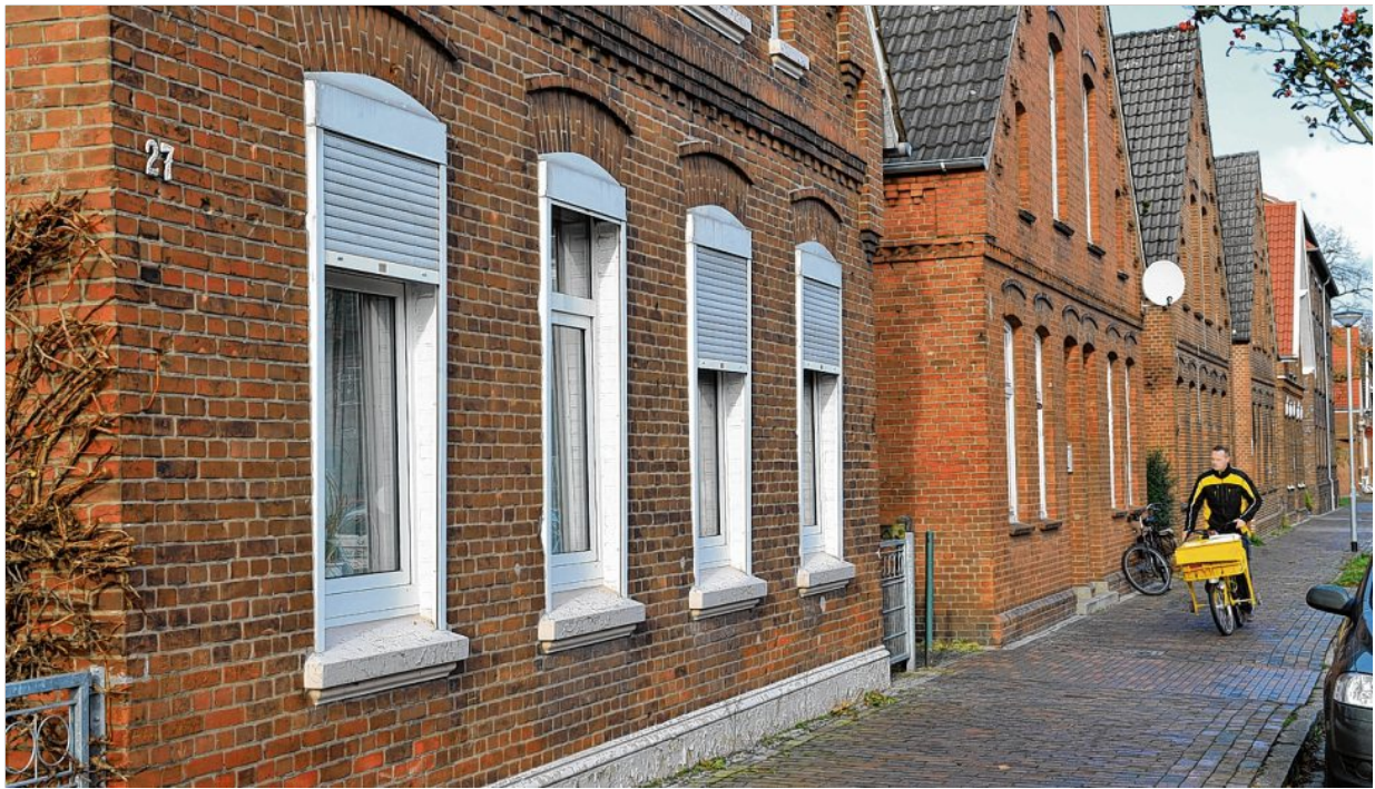
Das Klinikum Leer verzichtet auf die Häuser 27 bis 33 in der Großstraße.
