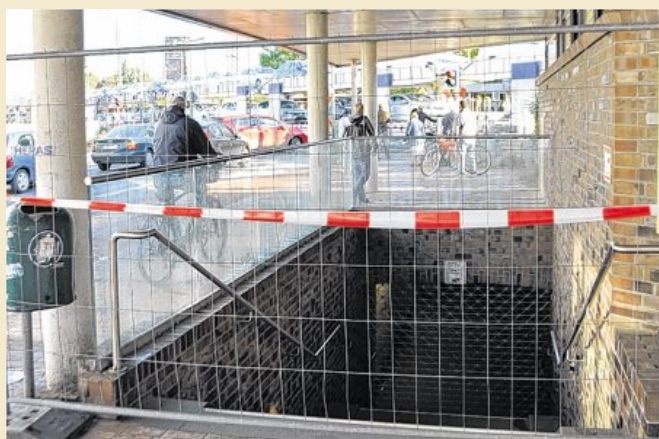
Der Tunnel in der Bremer Straße ist seit Herbst 2013 aus Sicherheitsgründen gesperrt. BILD: BEHRENDT
