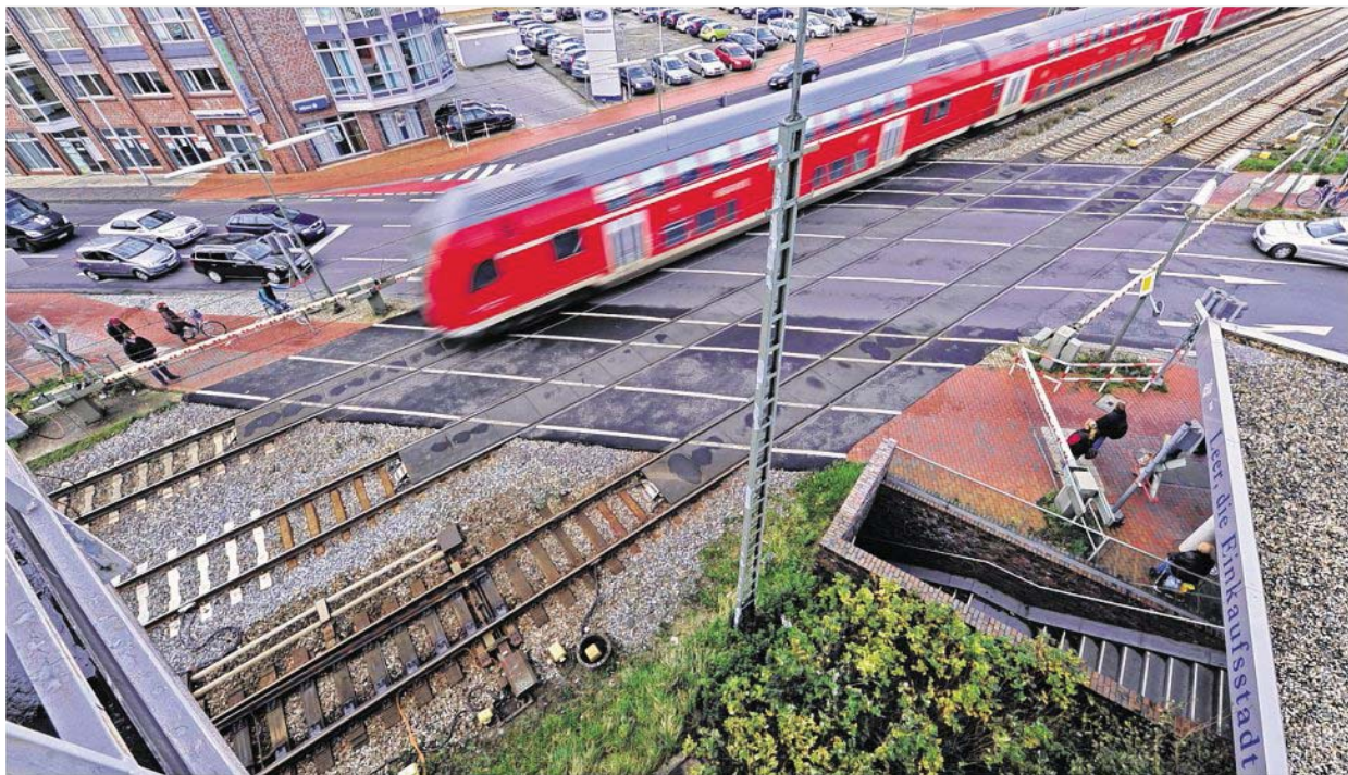
Baubeginn für den Tunnel, der unter der Bahnlinie hindurchführt, soll voraussichtlich im Jahr 2018 sein.
