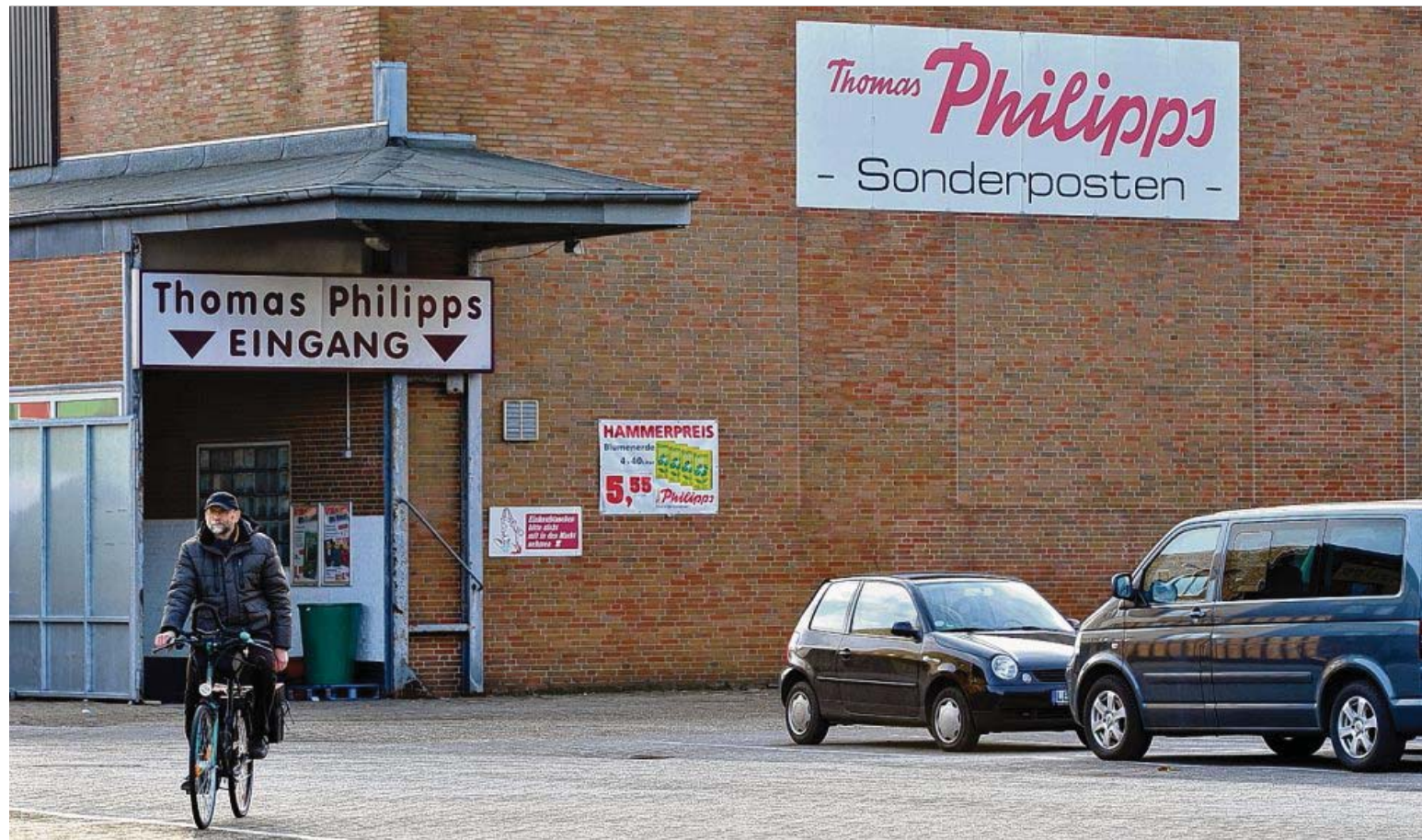
Das Gebäude, in dem sich der Sonderpostenmarkt Thomas Philipps befindet, wird abgerissen.
