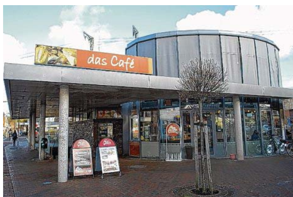
Ein weiteres Projekt der Sozialen Stadt: der Pavillon am Bahnübergang der Bremer Straße.
