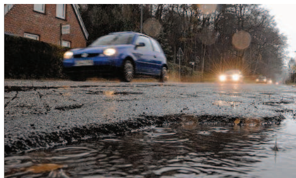
Der Logaer Weg muss dringend erneuert werden.
