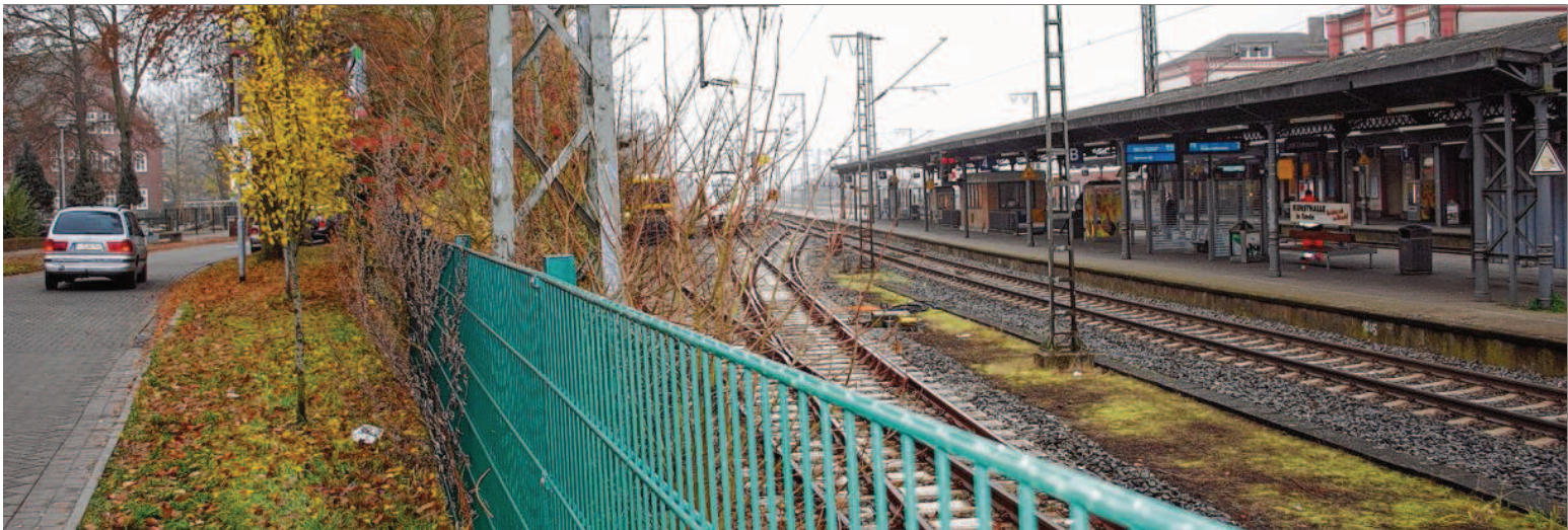
Die Überlegung war, einen vorhandenen Tunnel unterhalb des Bahnhofes (rechts) durchzustechen bis zur Reimersstraße (links).
