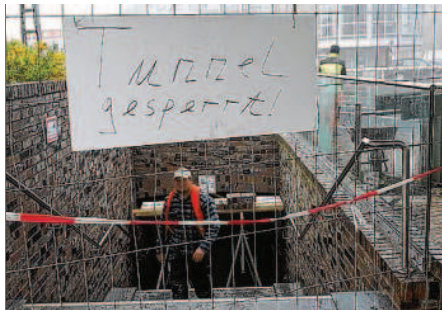
Der Fußgängertunnel in der Bremer Straße ist sanierungsbedürftig. Zuletzt war er zu Wochenbeginn gesperrt.
