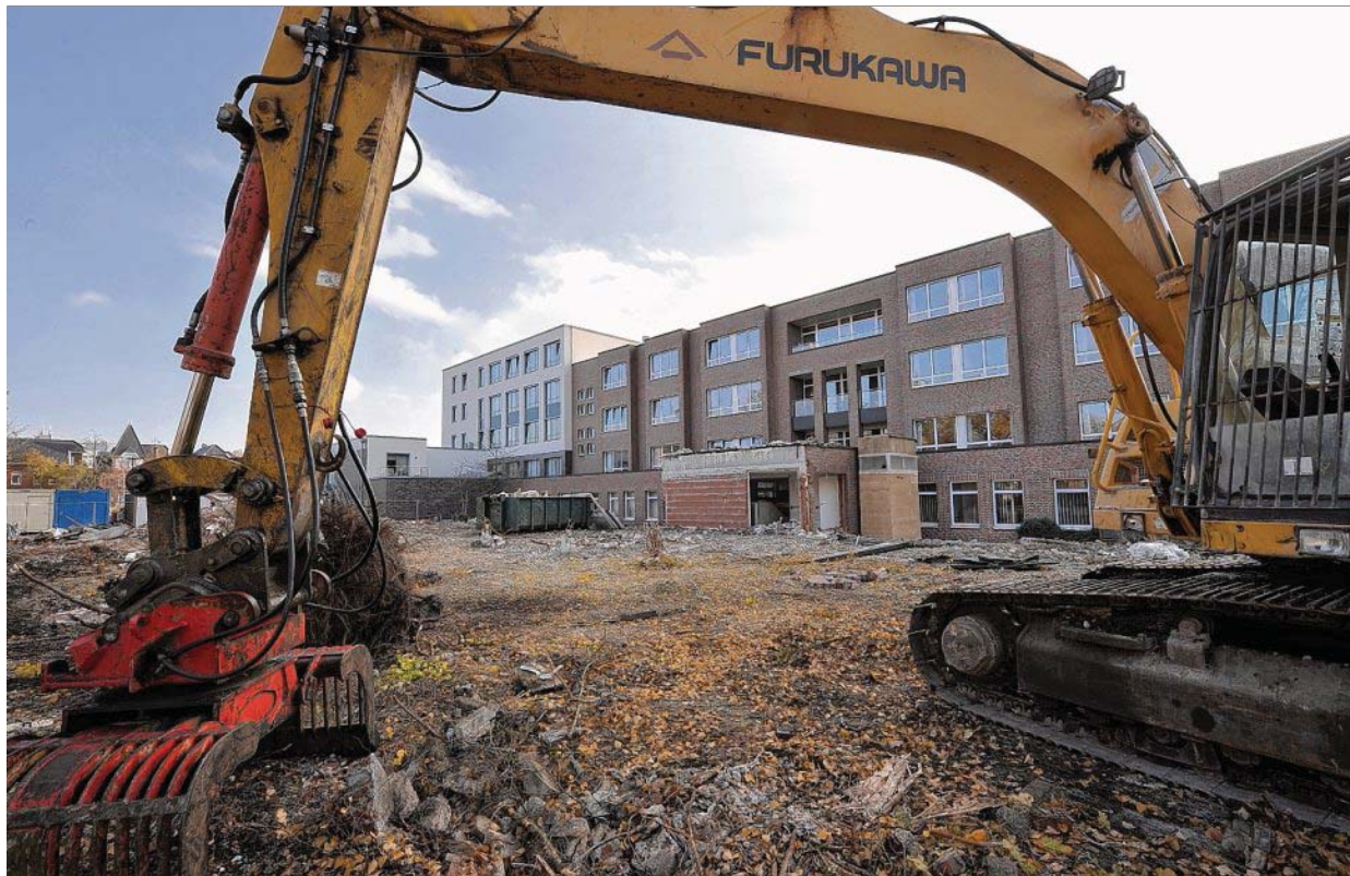
Wieder im Einsatz: In Leer haben Bagger gerade die Kinderklinik abgerissen.
