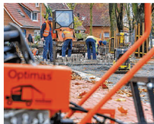
Auf einem 150 Meter langen Teilabschnitt wird die Straße nicht asphaltiert, sondern gepflastert.
