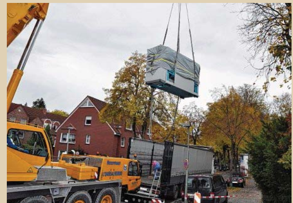
An einem Kran schwebt das Blockheizkraftwerk Richtung Klinikum.
