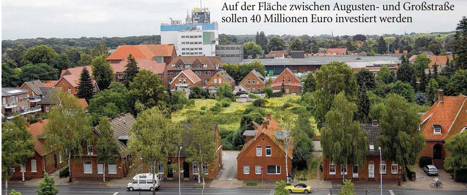
Einige Häuser an der Augustenstraße werden für die geplante Bebauung der hinteren Fläche abgerissen werden müssen.
