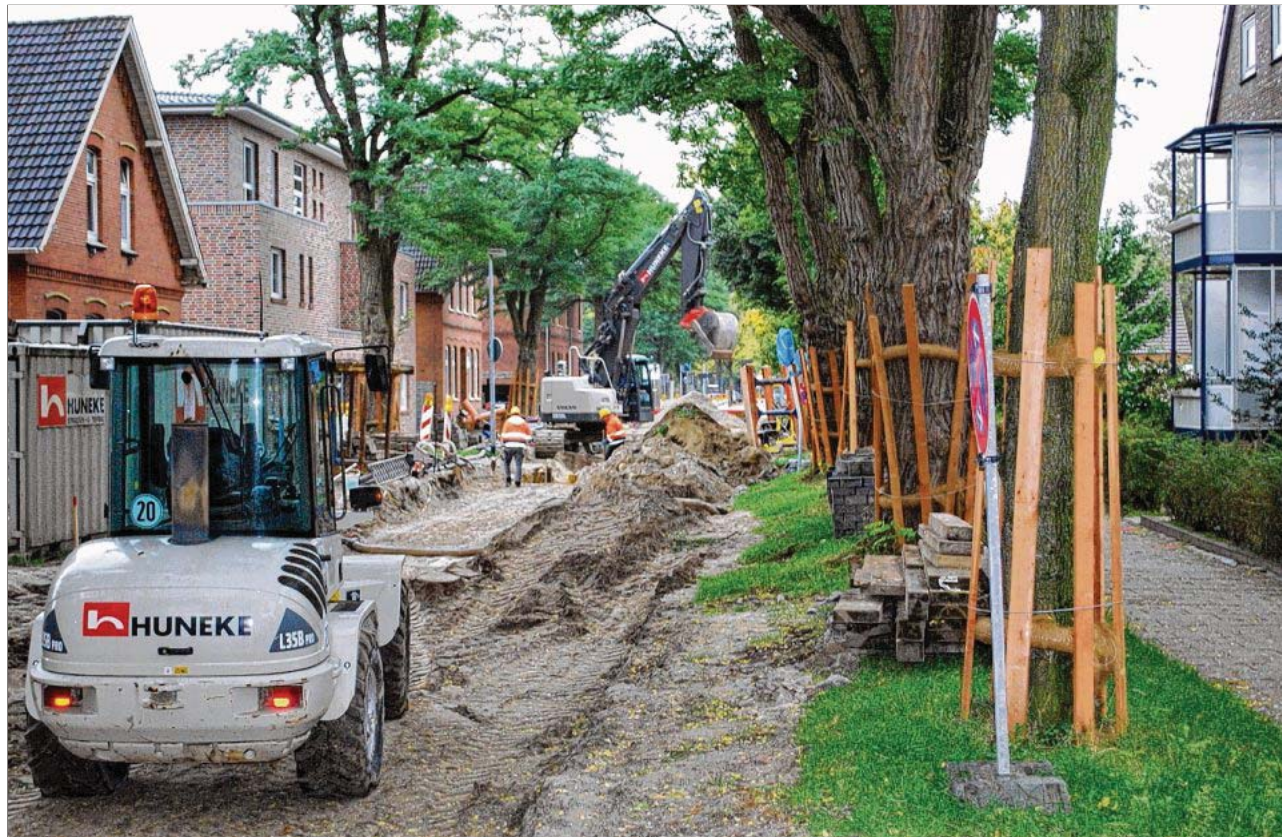
In der Christine-Charlotten-Straße wird derzeit die Kanalisation erneuert. 2013 folgt der Straßenausbau. BILD: BEHRENDT
