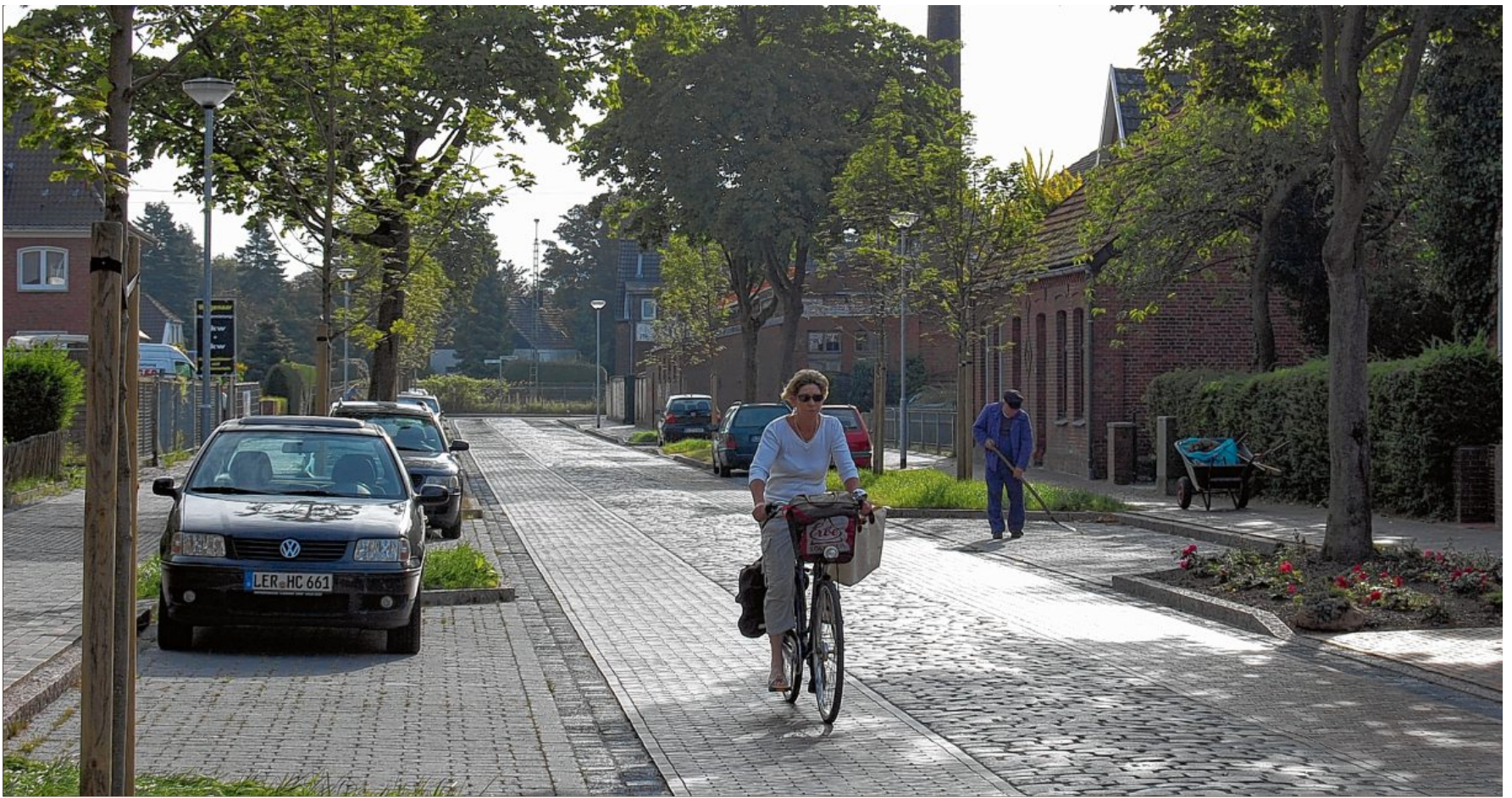
Die Annenstraße wurde im Juni dieses Jahres nach elf Monaten Bauzeit freigegeben. Die Straße ist jetzt mit Parkbuchten ausgerüstet. Radfahrern stehen verlinkerte Streifen zur Verfügung. BILDER: GRÄFE
