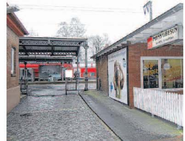
2014 soll rechts hinter dem Imbiss unter den Gleisen ein neuer Tunnel gebaut werden.
