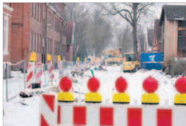
Wo der Scheltenweg die Großstraße quert, müssen noch Rohre verlegt werden.
