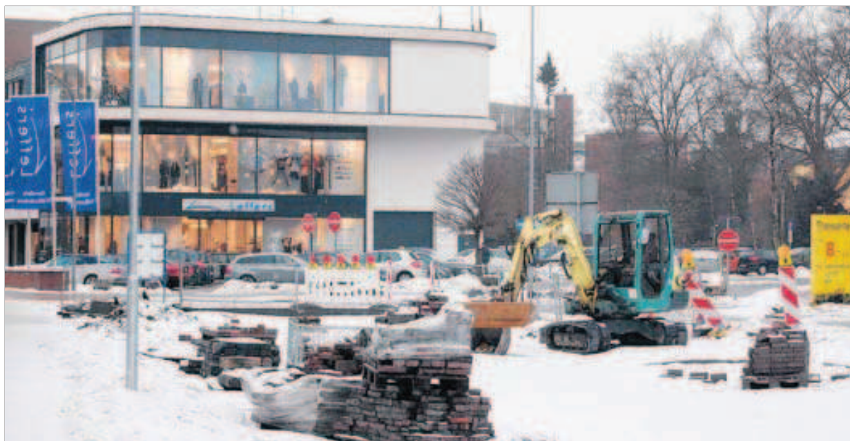
Bis auf 20 Meter kamen die Arbeiter beim Ausbau der Großstraße an die Friesenstraße heran, dann stoppte sie der Frost. Die Einmündung blieb eine Baustelle.
