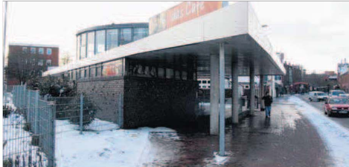
Ein Metallpfeiler steht mitten auf dem Bürgersteig. Er stützt das überhängende Dach ab.
