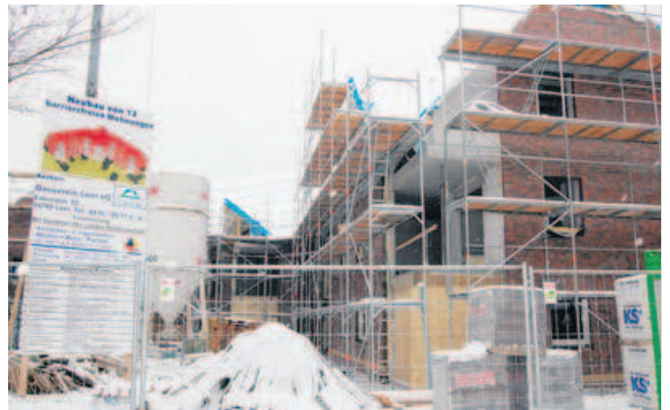
Der Rohbau steht bereits. Spielt die Witterung mit, soll das Gebäude im Mai bezogen werden.
