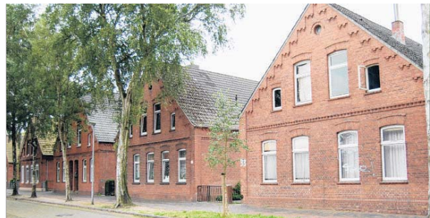
Die Häuser 33 (rechts) bis 27 an der Großstraße gehören jetzt ebenfalls der Klinik. Das Ensemble steht unter Denkmalschutz.
