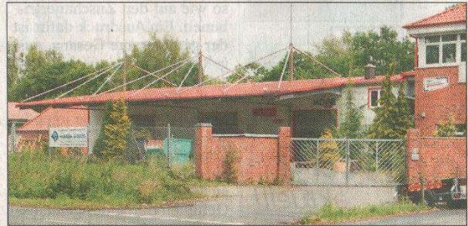
Das Gelände der insolventen Dachdeckerfirma wirkt verwahrlost. Jetzt will Lidl dort bauen. Foto: Gisela Robben
