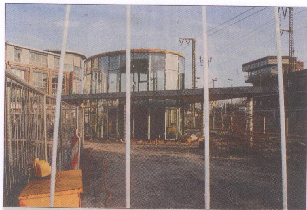
Noch eine Baustelle: Der Pavillon am Bahnübergang der Bremer Straße. Ostern rechnet die Verwaltung mit der Fertigstellung des Gebäudes. Foto: Nico Lindner
