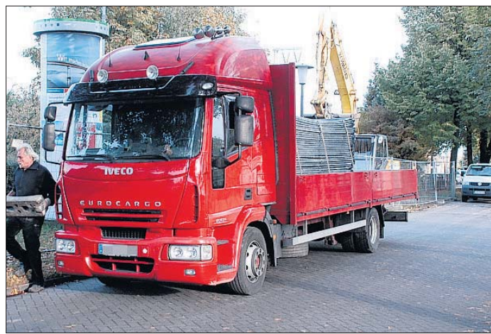
Mitarbeiter der Firma Huchtman richteten am Donnerstag eine Baustelle ein.
