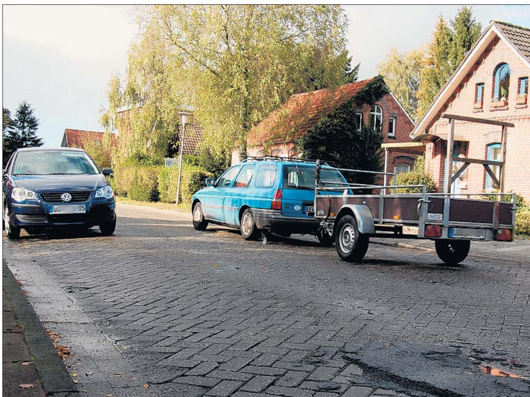
Der Logaer Weg ist streckenweise sehr uneben und weist zahlreiche Versackungen auf. Eine positive Folge ist, dass nicht schnell gefahren werden kann. BILD: GRÄFE
