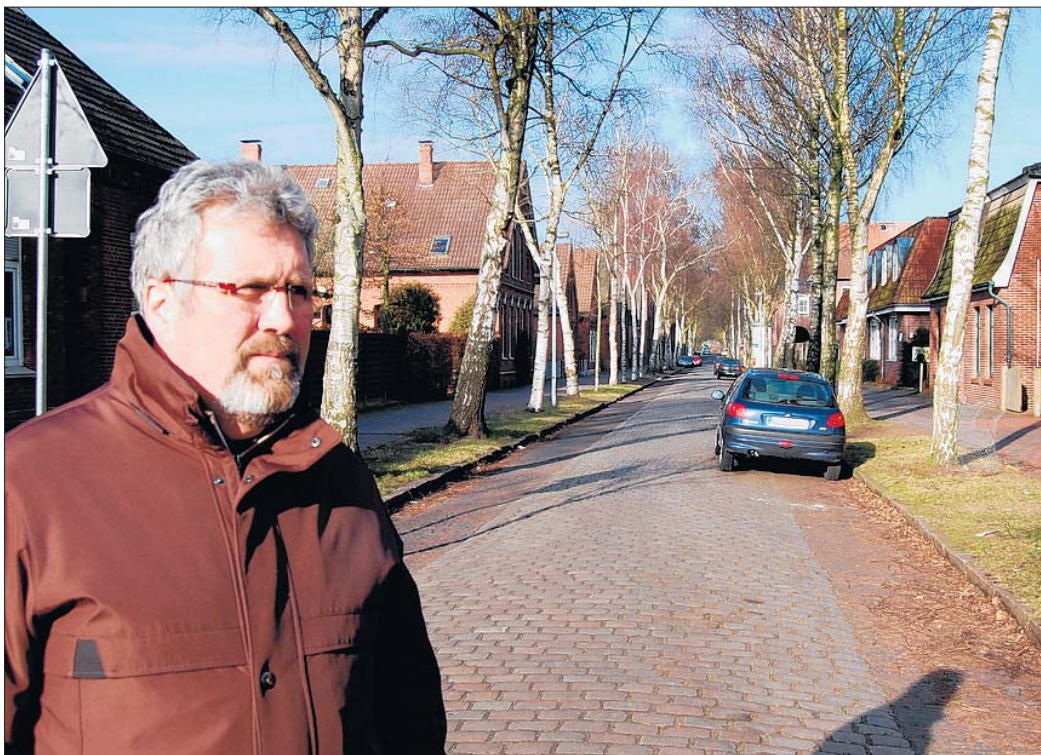
Heinz Sabath setzt sich seit Jahren zusammen mit einer Bürgerinitiative für die Großstraße ein. Deren Fahrbahn ist extrem gewölbt.
