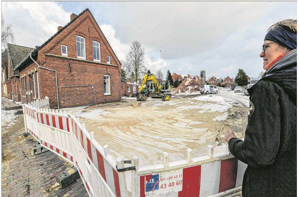
Gegenüber vom Klinikum an der Augustenstraße soll der vorübergehende Parkplatz entstehen.
