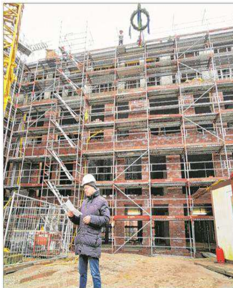
Helmut Hockmann, Geschäftsführer vom Bauunternehmen Heinrich Hockmann aus Westoverledingen, berichtet über den Bau der neuen Intensivstation.
