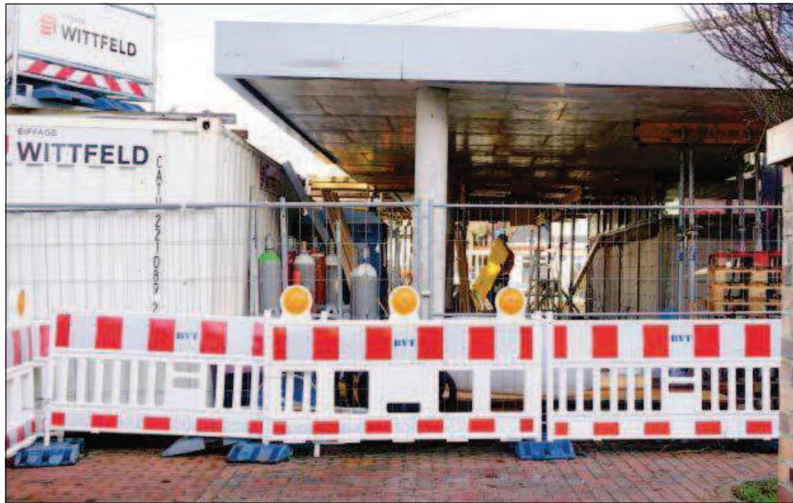
Aktuell ist am Bahnübergang und dem Tunnel noch eine große Baustelle.
