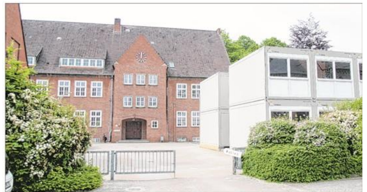
Die Container vor der Hoheellernschule werden auch in den kommenden Monaten noch benötigt.
