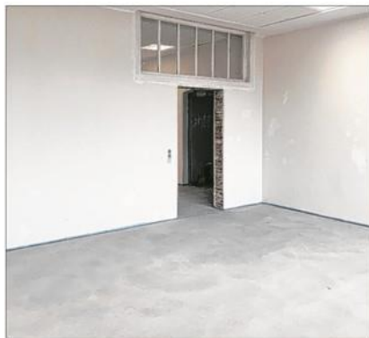
Vier Klassenräume mussten einen neuen Estrich bekommen.
