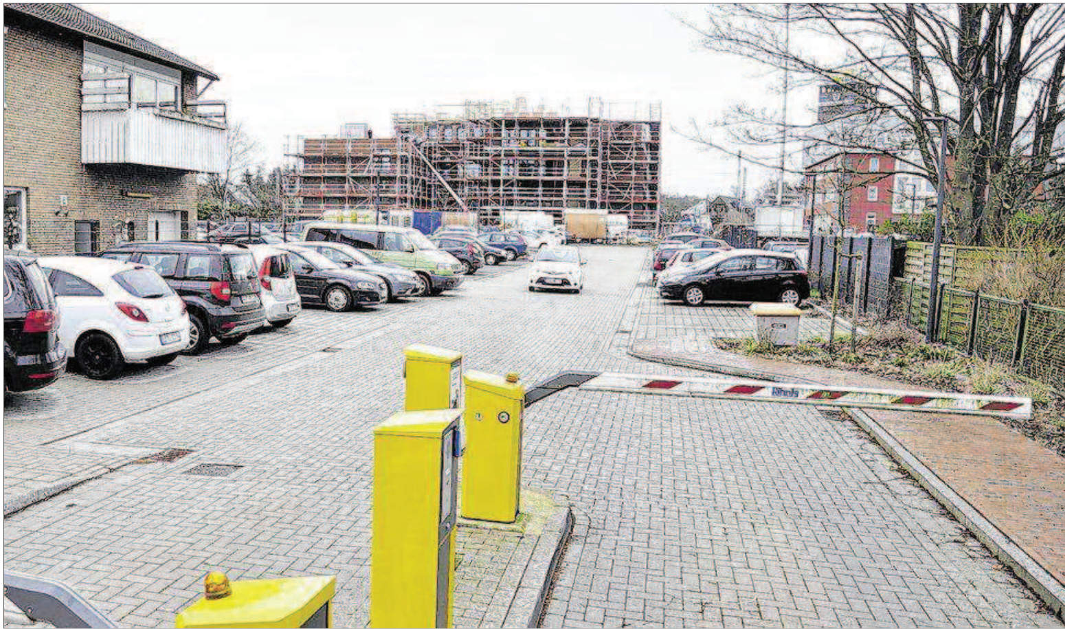
An der Großstraße soll auf der Parkfläche für die Klinik-Mitarbeiter ein neues Parkhaus entstehen. Im Hintergrund sieht man den Neubau des Seniorenheims an der Großen Roßbergstraße.
