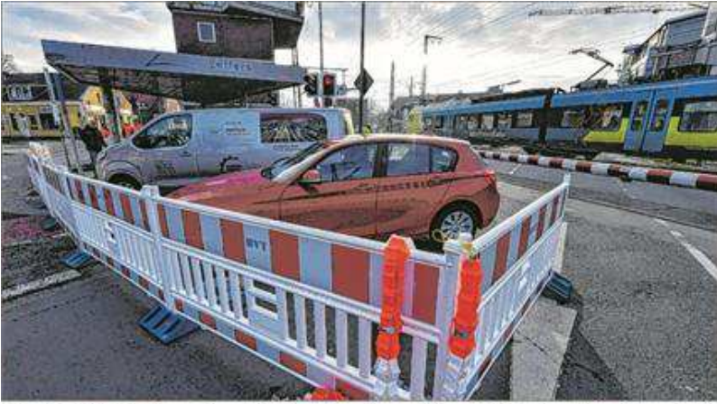
Ein BMW-Fahrer bog falsch ab und landete in der Baustelle am Bahnübergang.
