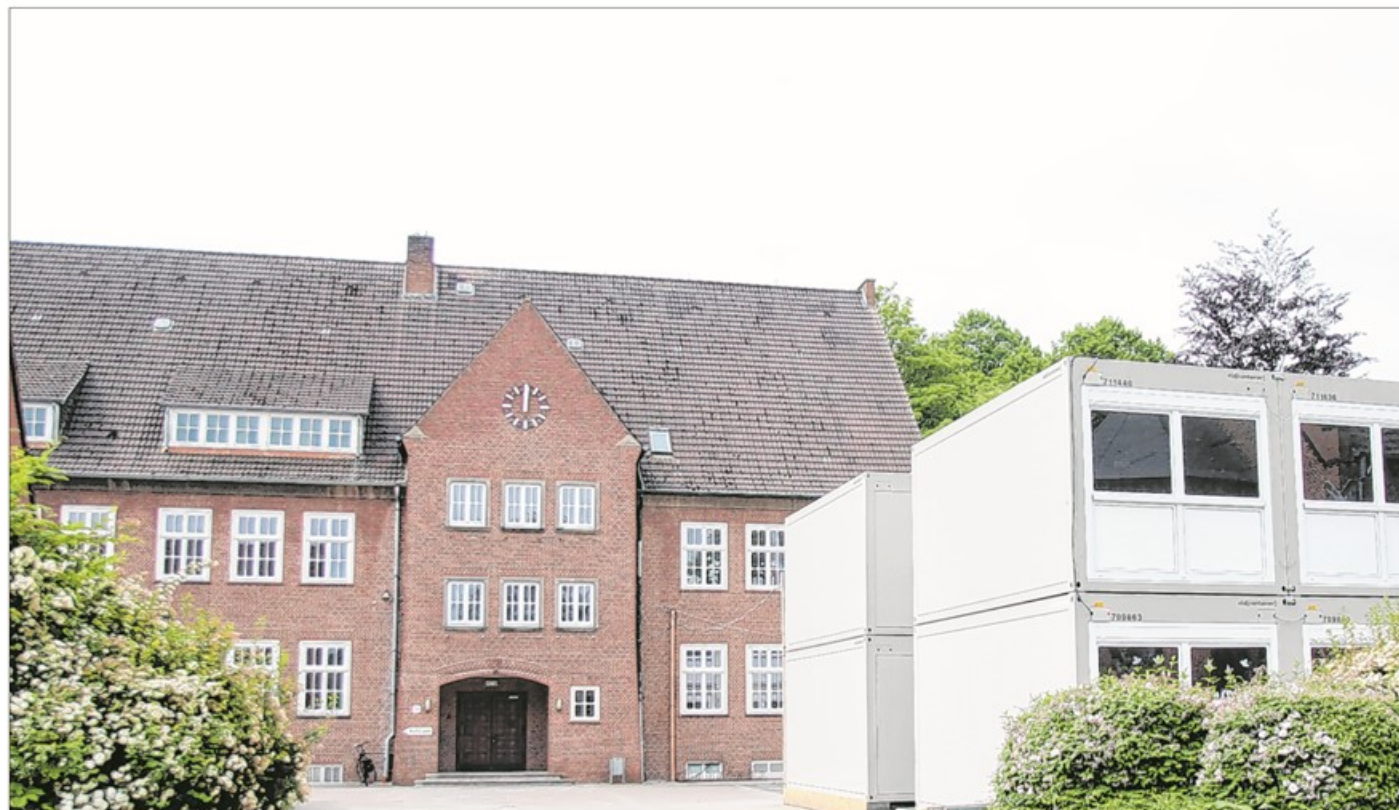
Ein Ende der Sanierungsarbeiten an der Hoheellernschule scheint wieder in weite Ferne gerückt.
