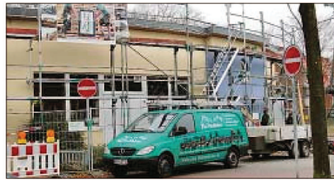
Dachdecker reparieren das Dach des Ledatreffs. Foto: Robben
