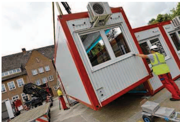
Anfang August wurden die ersten Container auf dem Schulhof aufgestellt.
