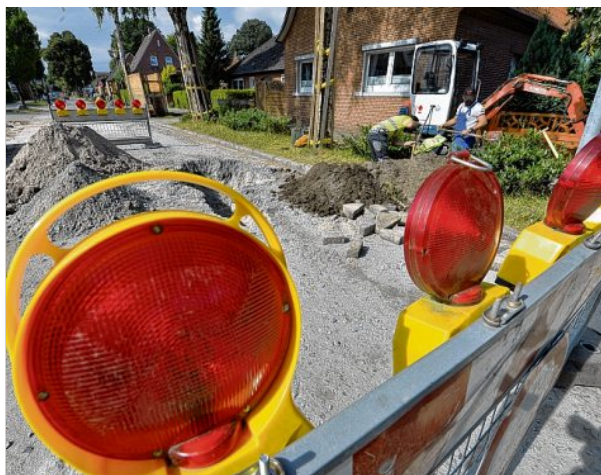
Auch in der Johannstraße laufen die Kanalisationsarbeiten. Derzeit werden Hausanschlüsse hergestellt.
