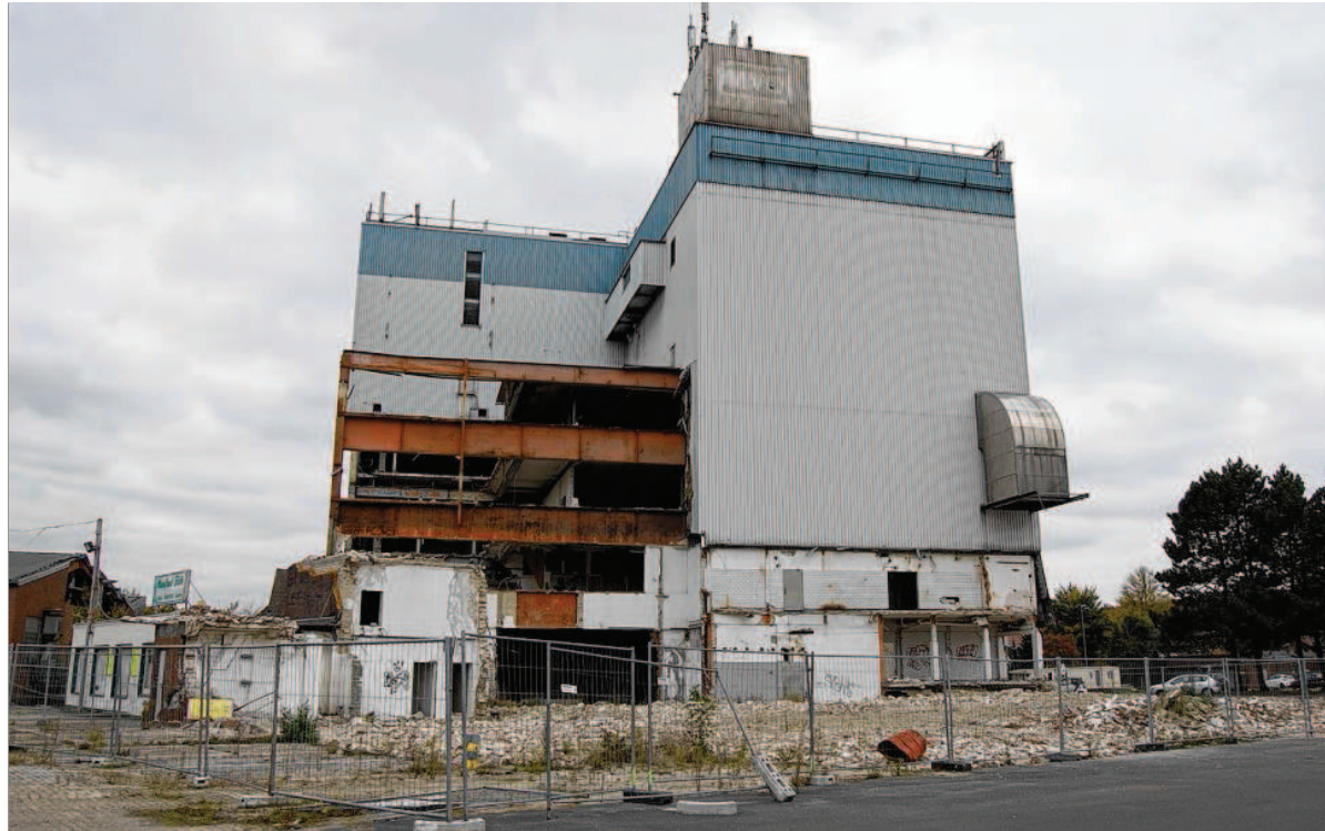
Auf dem ehemaligen MZO-Gelände plant die Radsan Park GmbH einen modernen Wohnpark. Der Turm wird Anfang des kommenden Jahres abgerissen.
